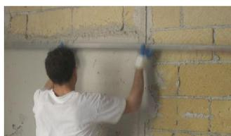
Realizzazione di intonaci su superfici verticali e/o orizzontali eseguiti a mano. L'applicazione manuale dell'intonaco esterno richiede le seguenti accortezze ai fini di buoni risultati:
